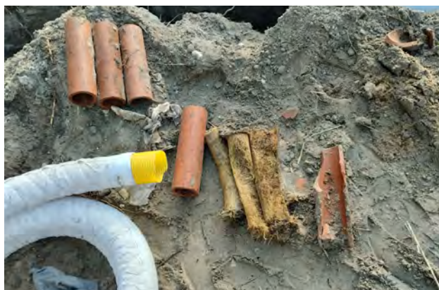
Naprawa zapchanych rur drenarskich w Woli Mrokowskiej.
