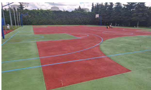
Nowa Iwiczna modernizacja boiska.
