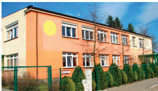
Gminne Przedszkole w Mysiadle, ul. Osiedlowa 4.
