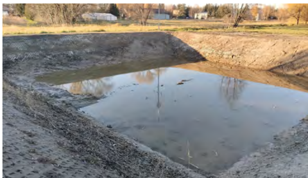
Staw w Mrokowie po wykonaniu prac.
