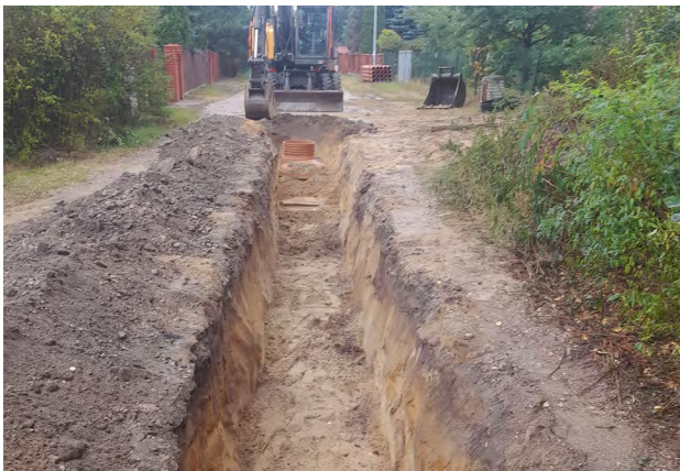
Budowa sieci wodociągowej w Stefanowie.
