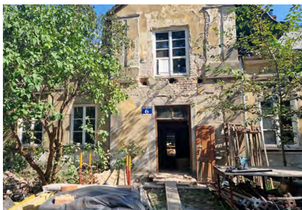
W trakcie remontu.
