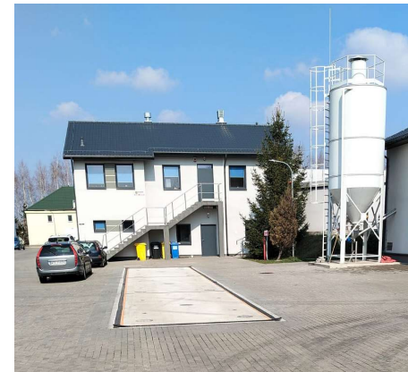
Waga do pomiaru ilości osadu – OŚ Zamienie.
