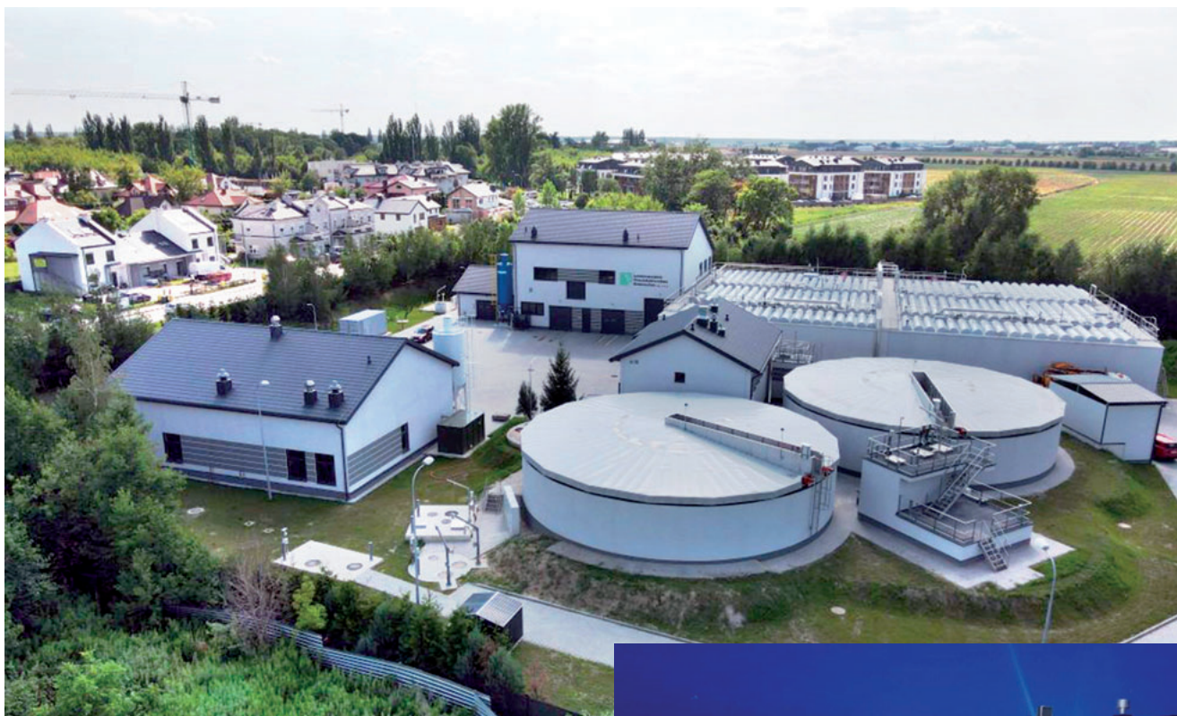
Obiekt oczyszczalni ścieków w Zamieniu
