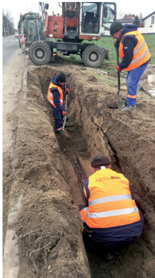
Budowa kanalizacji sanitarnej tłocznej (trasa Nowa Iwiczna i Nowa Wola) wraz z przepompownią ścieków
