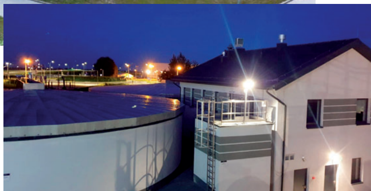
Budynek socjalny oraz osadnik wtórny
