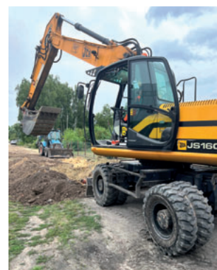
Budowa kanalizacji sanitarnej tłocznej (trasa Nowa Wola i Zgorzała)
